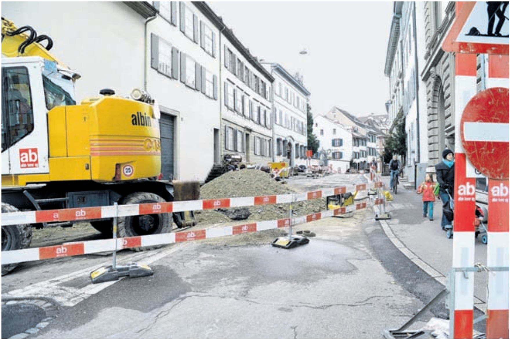
Baustelle auf der Stadtlauf-Strecke. Gestern Nachmittag um 16 Uhr war in der Rittergasse an vieles zu denken, nur nicht daran, dass heute Abend Tausende Läufer und Läuferinnen diese Stelle passieren müssen. Das Baudepartement versicherte jedoch, dass die Gruben bis heute Abend zugeschüttet sein werden. Foto Elena Monti
